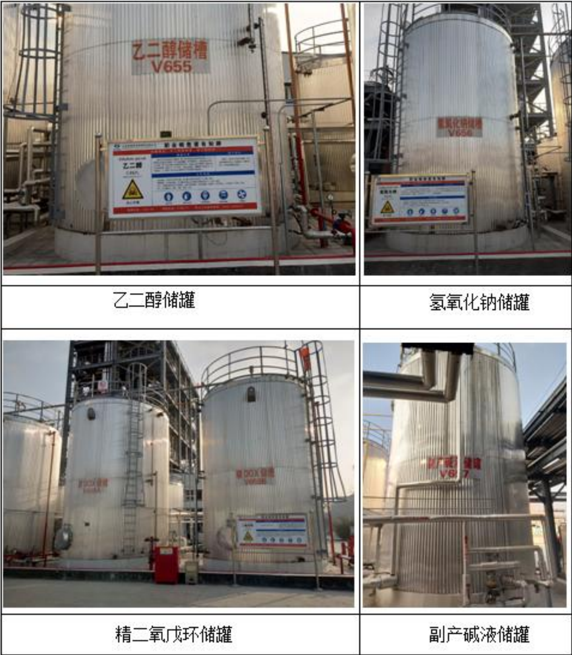
图 4.1-2 一期工程储罐区
