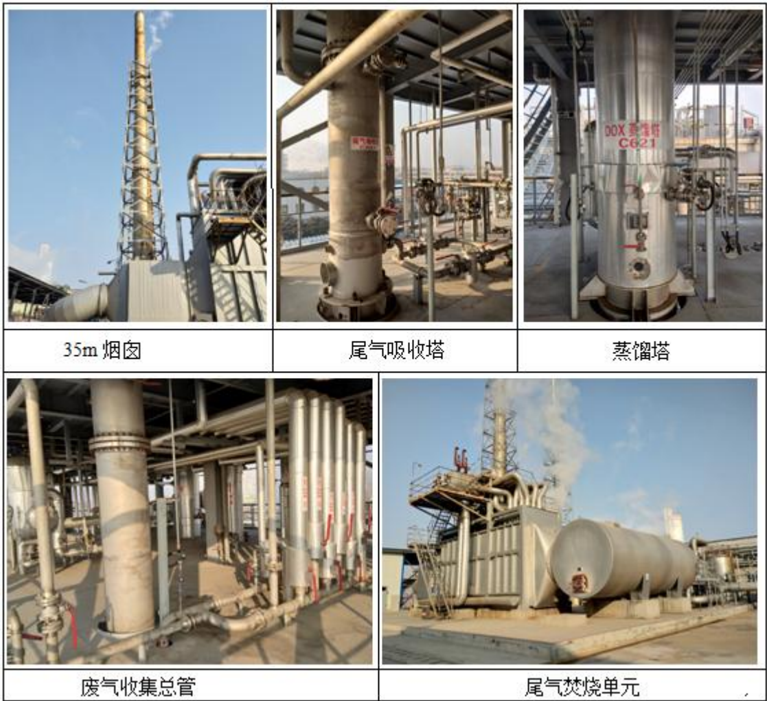
图 4.1-4 聚甲醛焚烧炉实际建设情况
