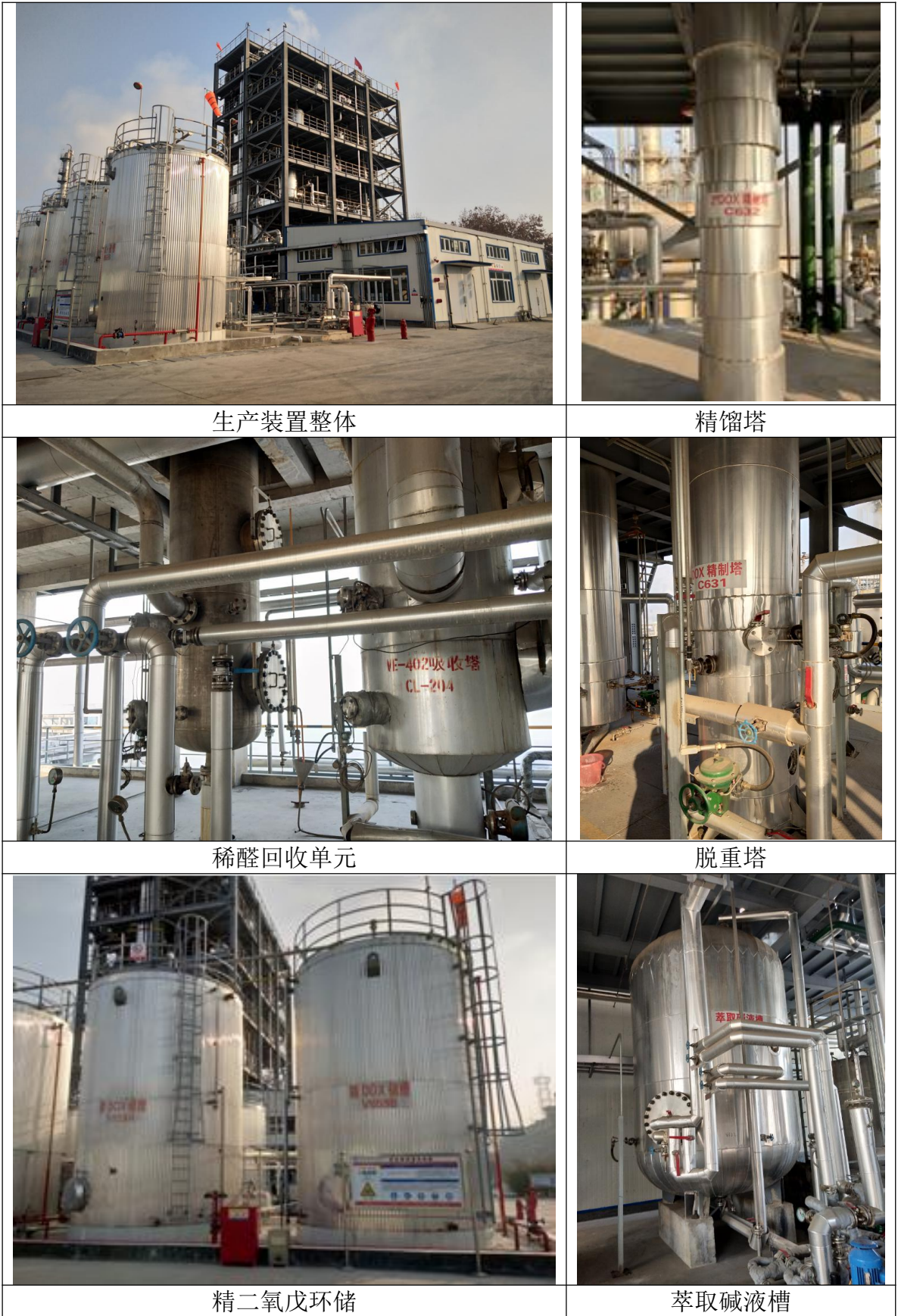
图 4.1-6 兗矿鲁化聚甲醛稀醛回收系统实际建设情况
