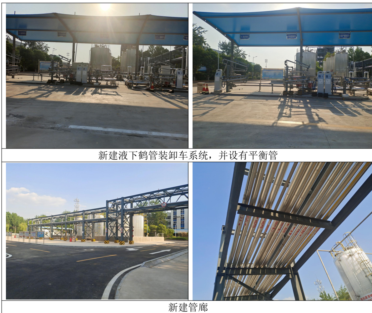
图 3.2-1 二期工程新建储罐区、装卸车系统及管廊
